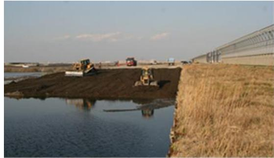
＜ダンプトラックによる建設発生土の受入、ブルドーザーによる撒出し＞
